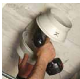
Fissaggio del supporto.
